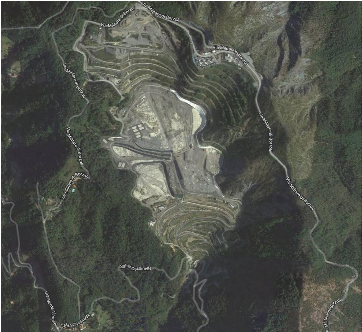
Fig. 20: L'area della discarica di Scarpino - Genova (Google Maps, 2016)
